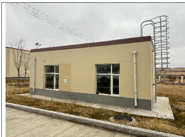
尾水提标项目调节池
