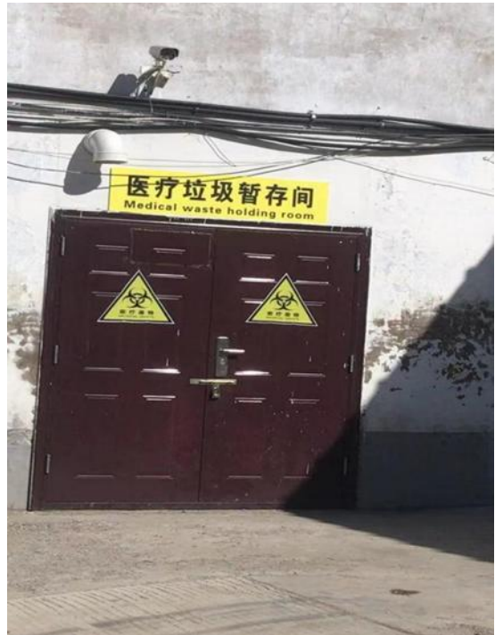
人民医院医疗废物暂存间
